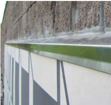
Détail de la murale extérieure, La lumière vient de l'espace (1983), de Marc Martel, réalisée sur une façade de l'école Les primevères, à Québec. Elle est protégée par un solin.
